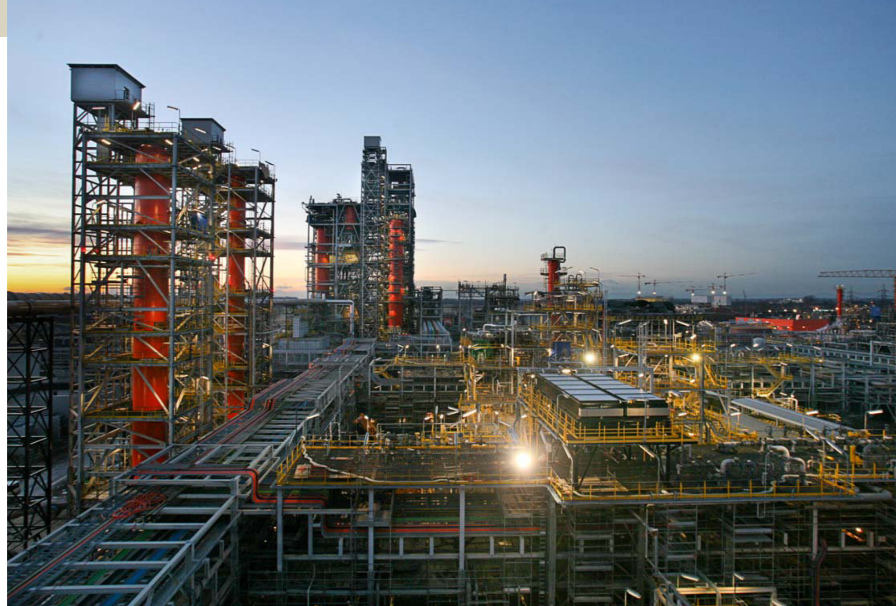
La raffineria di Sannazzaro de' Burgondi (PV) in cui è sviluppata la tecnologia EST
